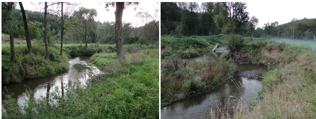
Obr. 40: Přestože koryto není zřejmě opevněné, je nadměrně zahloubené a erozním vývojem se dále se zahlubuje
