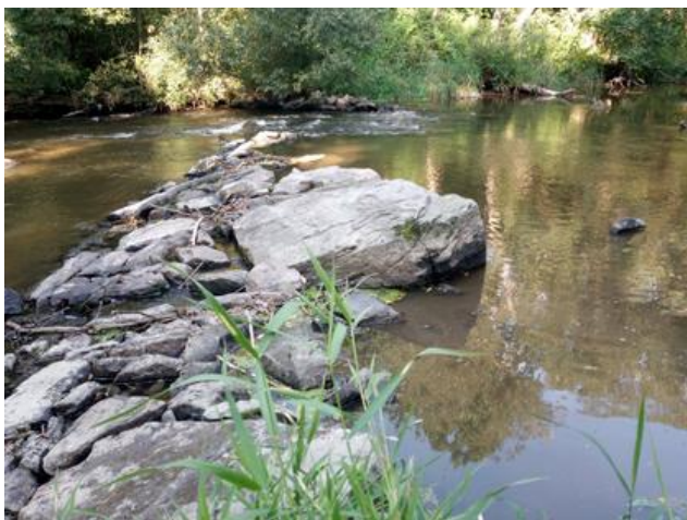
Obr. 45: Renaturovaný jez se zaniklou souvislou přelivnou hranou – je průchozí pro vydra, pro raky i pro většinu druhů ryb (průchodnost pro jednotlivé skupiny ryb bude závislá na konkrétních podmínkách).
