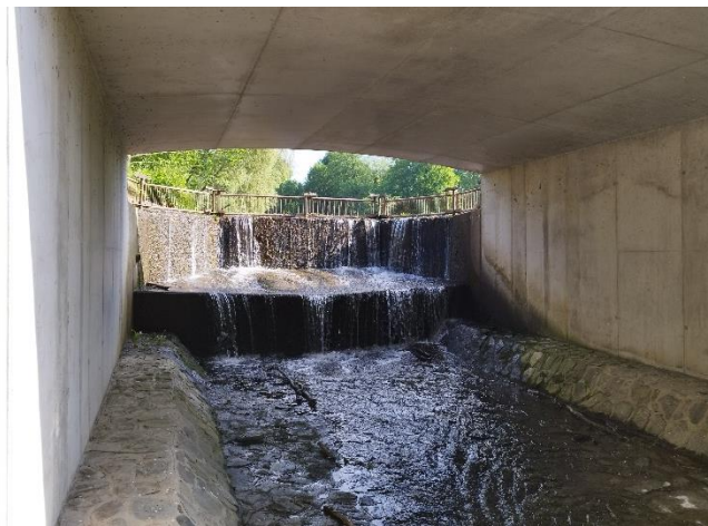
Obr. 2: Bezpečnostní přeliv – průchodnost pro vydry: Neprůchodný BP (vlevo) – svislá přelivná hrana výšky 1 m je nepřekonatelná pro vydry i pro většinu dalších živočichů. Zde je bariérový účinek navíc zvýšen předsazenou ocelovou lávkou s česlemi. Zvířata migrující podél vodního toku jsou nucená přebíhat přes frekventovanou silnici; vpravo - neprůchodný BP z pohledu vydry migrující proti proudu vodního toku. Vydra je v tomto případě schopná projít most pod silnicí, narazí ale na svislou zeď bezpečnostního přelivu, jehož bariérový účinek je navíc zvýšený kovovými česlemi. Zvíře nemá jinou možnost než se vrátit a pokusit se přeběhnout vrchem hráze rybníka s frekventovanou silnicí.
