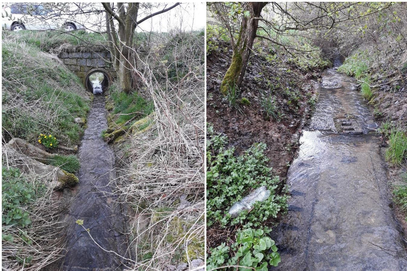
Obr. 20: Žlabovky ve dně a plné betonové tvárnice ve březích vlevo (omezená komunikace s podzemní vodou vlivem technické úpravy), vegetační tvárnice vpravo
