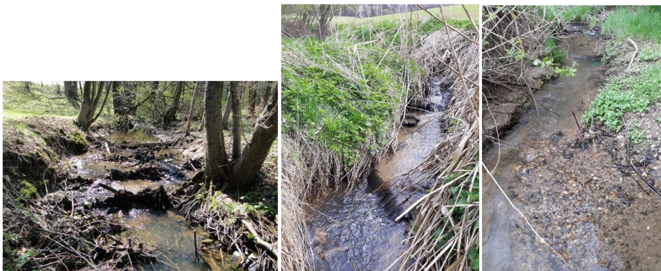
Obr. 32: Působení renaturačních procesů – úprava částečně odnesená, překrytá sedimenty a četnými akumulacemi říčního dřeva (vlevo), uvolnění a odnos opevnění (uprostřed) – uvolnění a odnos opevnění jsou charakteristiky původně upraveného úseku VT, pokud se opevnění dostane do přírodě blízkého úseku dále po toku, mělo by být uvedeno v rámci charakteru a substrátu dna (např. popisem v poznámce) , překrytí úpravy značnou vrstvou sedimentů a rozvolnění trasy (vpravo)
