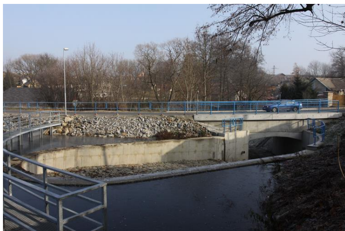
Obr. 2: Bezpečnostní přeliv – průchodnost pro vydry: Neprůchodný BP (vlevo) – svislá přelivná hrana výšky 1 m je nepřekonatelná pro vydry i pro většinu dalších živočichů. Zde je bariérový účinek navíc zvýšen předsazenou ocelovou lávkou s česlemi. Zvířata migrující podél vodního toku jsou nucená přebíhat přes frekventovanou silnici; vpravo - neprůchodný BP z pohledu vydry migrující proti proudu vodního toku. Vydra je v tomto případě schopná projít most pod silnicí, narazí ale na svislou zeď bezpečnostního přelivu, jehož bariérový účinek je navíc zvýšený kovovými česlemi. Zvíře nemá jinou možnost než se vrátit a pokusit se přeběhnout vrchem hráze rybníka s frekventovanou silnicí.
