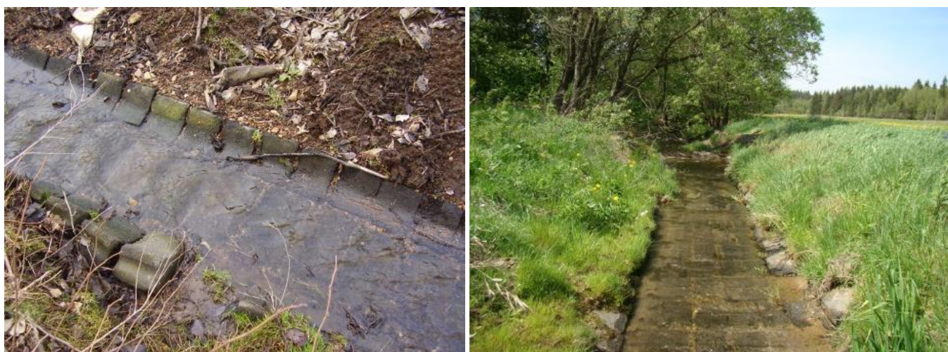
Obr. 21: Žlabovky vlevo (částečně omezená komunikace s podzemní vodou), plné tvárnice (vpravo) doplněné kamennou patkou v březích (často bývá patka překryta sedimenty nebo vegetací)
