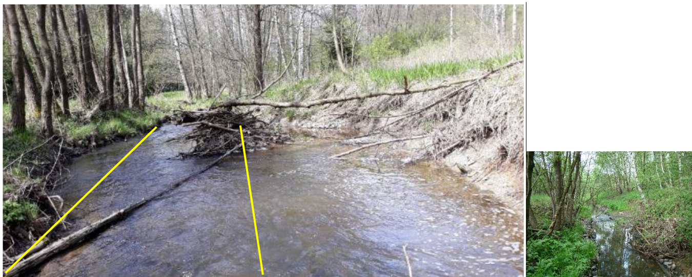
Obr. 31: Působení renaturačních procesů – odnos opevnění břehů kulatinou, výrazné nátrže při pravém i levém břehu a rozvolnění trasy boční erozí, vznik akumulčních tvarů dna a hromadění říčního dřeva; žlutými liniemi naznačena trasa původně opevněného koryta; zároveň se jedná o příklad břehové eroze v souvislosti s pozitivním působením renaturačních procesů (viz parametr 5), na snímku vpravo je stejný profil před cca 12 lety
