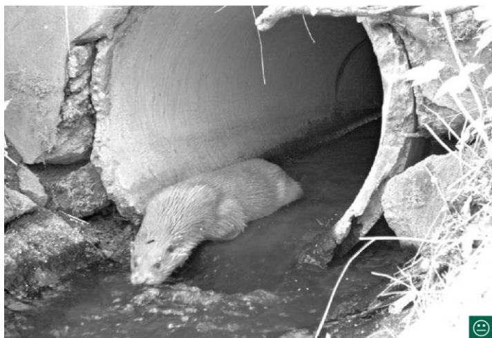
Obr. 50: Trubní propustky s malou hloubkou vody jsou pro vydra průchodné
