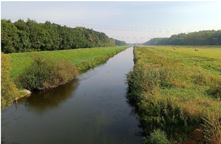
Obr. 17: Úvalovité údolí s široce vytvořenou údolní nivou (široké ploché nivy zpravidla dolních toků významných vodních toků, např. Polabí, Jižní Morava, niva více než 200 m na každé straně avšak často ohrázená – prostor inundace výrazně omezen)
