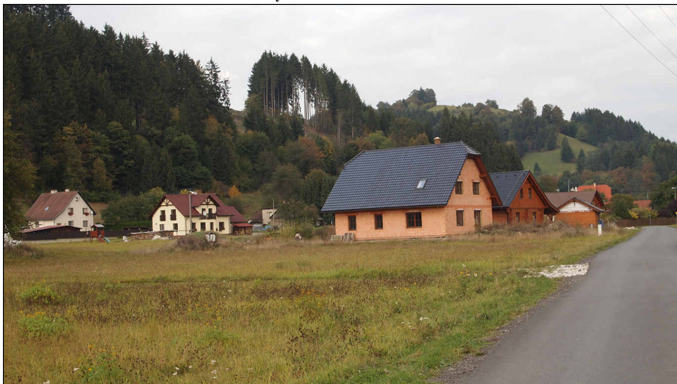
Pohled na satelitní zástavbu v lokalitě Bařiny
